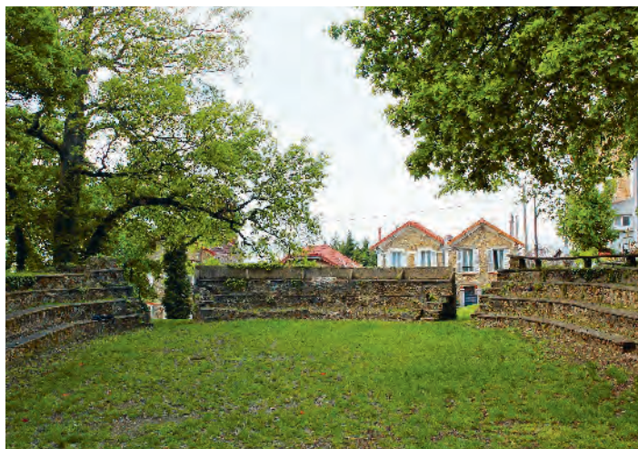
Les gradins d'origine à restaurer © Ville de Villeneuve-Saint-Georges
